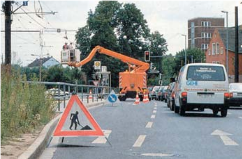
Bild 3-5: Einsatz im öffentlichen Verkehrsbereich und in der Nähe von Freileitungen
